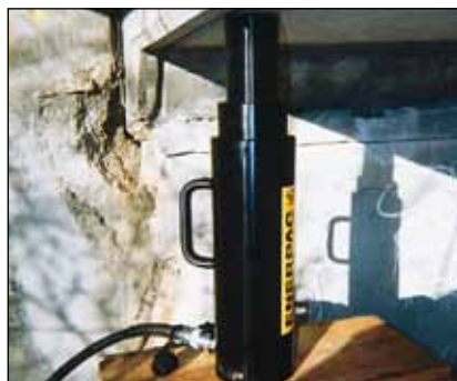
◀ Vérin Aluminium RACL-1506 avec écrou de sécurité, utilisé dans le cadre d'un maintien prolongé en position haute d'un tablier de pont lors d'une opération de maintenance.
